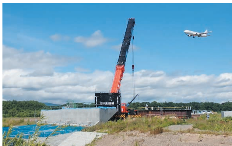
高規格道路工事の様子
