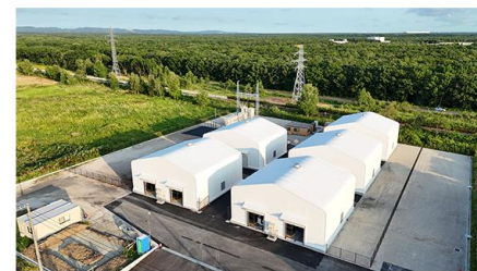
図3 「EVバッテリー・ステーション千歳」外観 （奥に写る送電鉄塔を通じて電力系統へ直接接続される）
