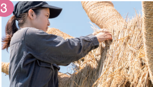
編んだわらのシートを骨組みに付けていきます。
