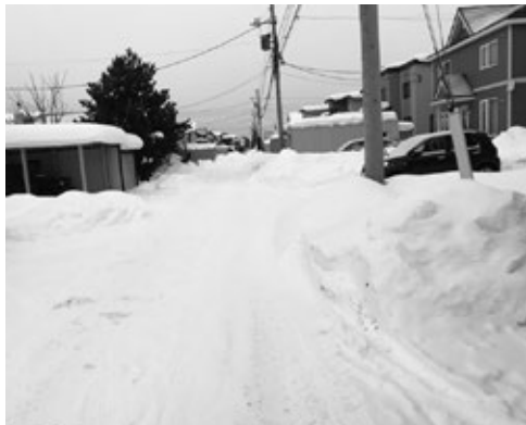
除排雪されていない町道
