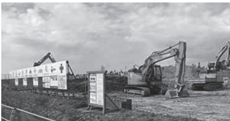
建設工事中の葬斎場現場
