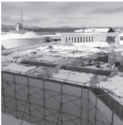
工事中の新庁舎
