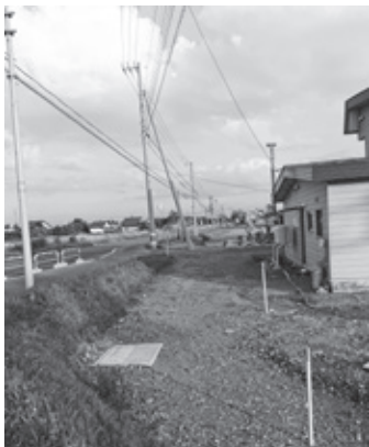
歩道拡張工事
