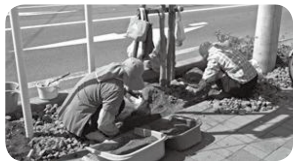
【砂利をよけ、土を入れる作業の様子】
