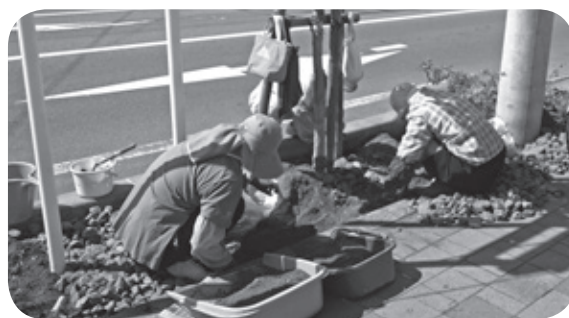
【砂利をよけ、土を入れる作業の様子】
