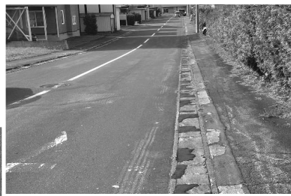
パッチワーク側溝蓋の施工後
