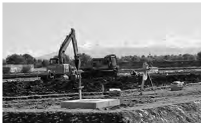
国営緊急農地再編整備事業工事状況
