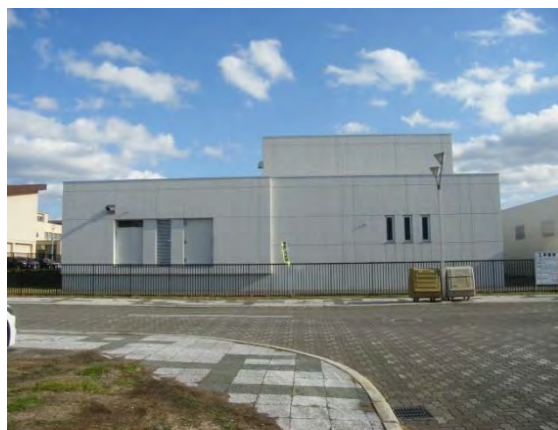
東神楽町配水センター
