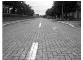
インターロッキング舗装
