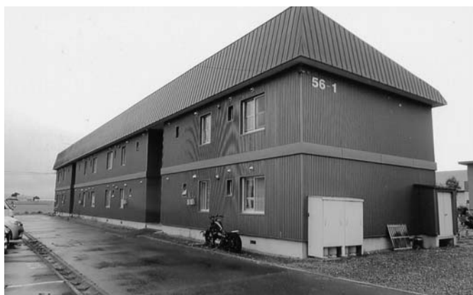
長い間空き家になっている東聖団地「104」号室
