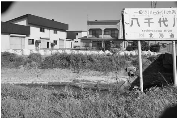
八千代川 大型土のう
