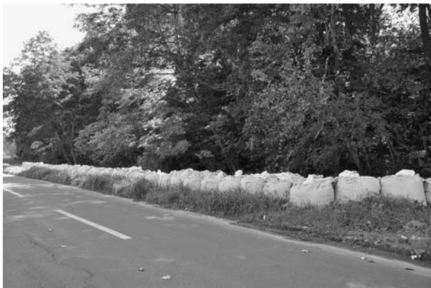
稲荷地区 大型土のう
