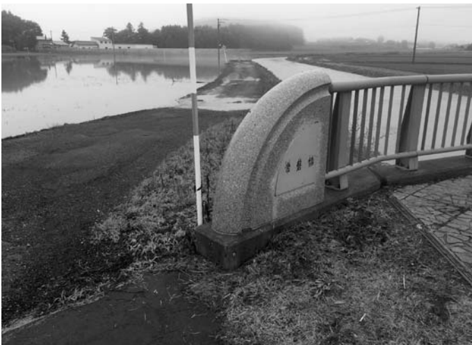
八千代川氾濫（常盤）
