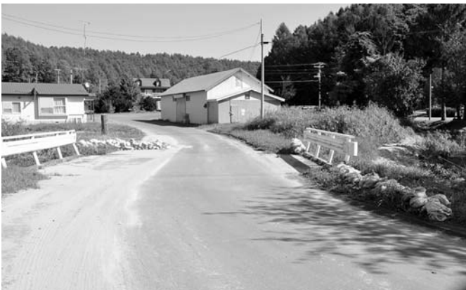
土のう袋を設置した被害地域
