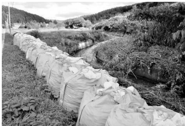
氾濫河川現場
